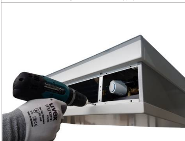
III. : 9: Fixer l'habillage à l'aide de vis
