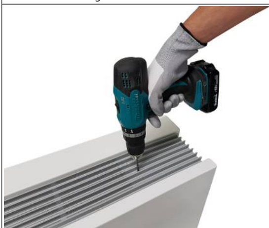
III. : 10: Visser la grille d'aspiration d'air.
