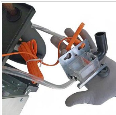
III. : 76: Nettoyer le contacteur à flotteur.
